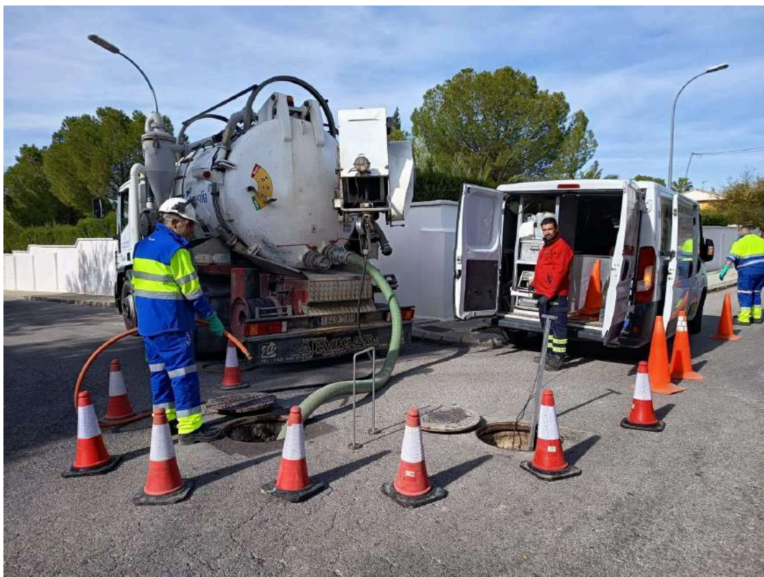
Trabajos de Aqualia en la red de saneamiento de Jaén capital.
