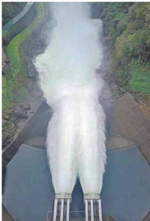
Dos aliviaderos ayer, a plena potencia.
