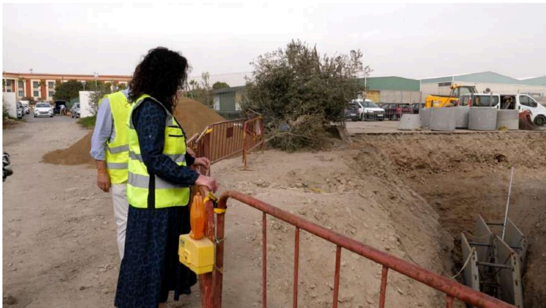
La alcaldesa ha visitado el inicio de los trabajos de la tubería.
